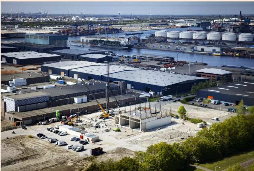
Het bouwterrein van datacampus SilverFalcon. Het maximale elektriciteitsverbruik van dit toekomstige datacenter staat gelijk aan de stad Haarlem. Foto: Ramon van Flymen voor het FD
