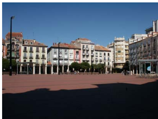
Fotos – Varias actuaciones de peatonalización ya finalizadas en 2006. Fuente: Propia
